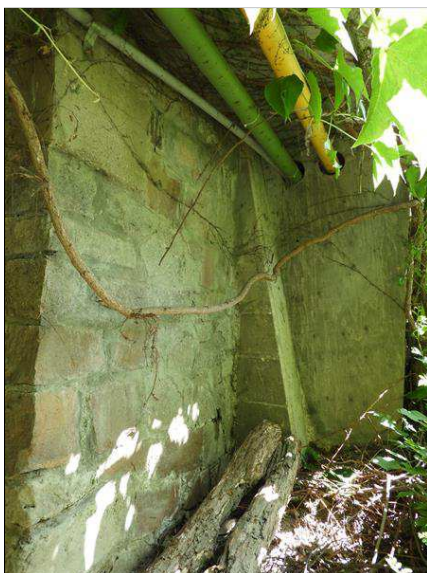
Detail křídla OP1 zleva - trhliny ve spárách, stopy po zatékání
