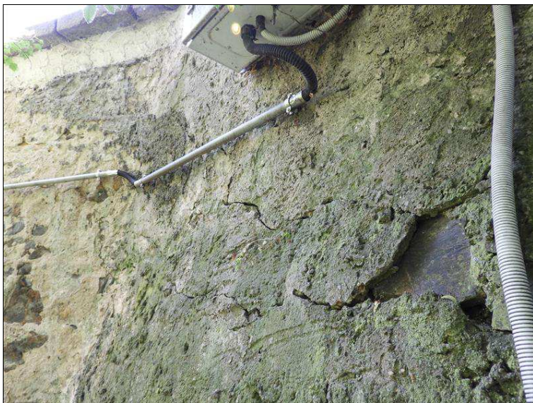
Detail křídla OP1 zleva - trhliny ve spárách, stopy po zatékání
