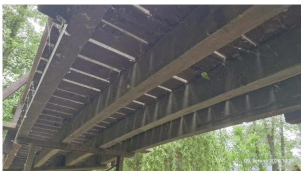
Podhled NK 2. mostní pole
