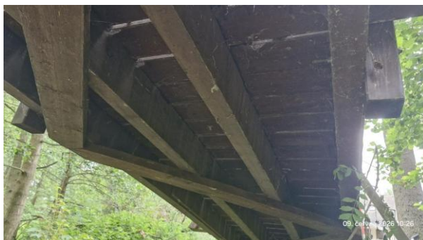
Podhled NK 1. mostní pole
