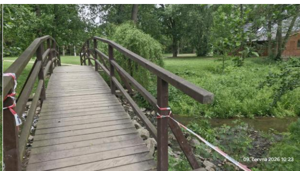
Pohled na zábradlí vpravo na začátku lávky
