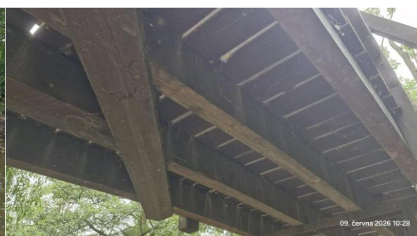
Podhled NK 3. mostní pole
