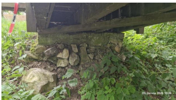
Pohled na OP1
