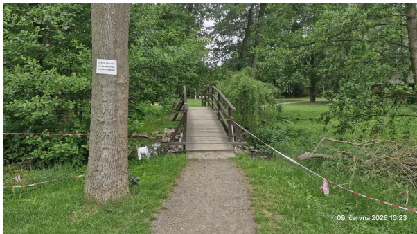
Pohled na začátek lávky ve směru popisu
