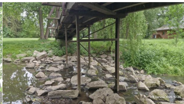
Pohled na podpěru P2 od OP1
