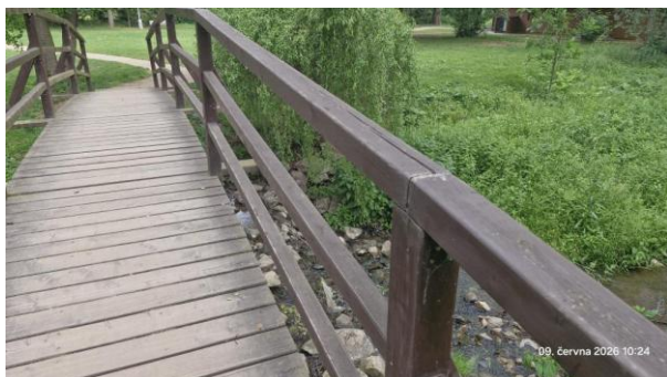
Detail pravého zábradlí
