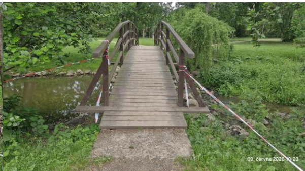
Pohled na začátek lávky ve směru popisu
