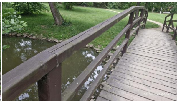
Detail levého zábradlí
