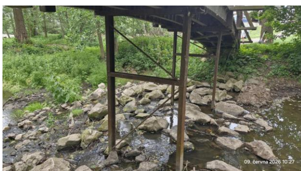
Pohled na podpěru P3 od OP4
