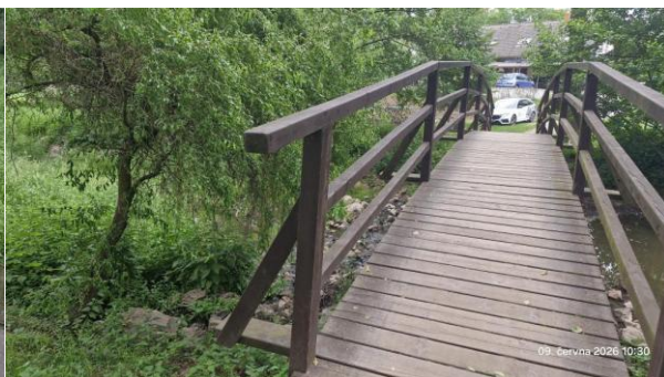
Pohled na zábradlí vpravo na konci lávky
