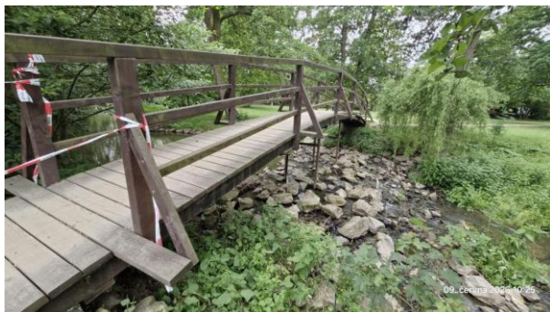
Pohled na lávku zprava
