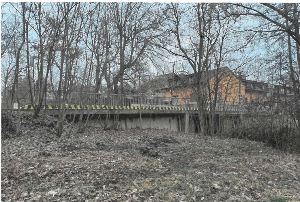
Celkový pohled na mostek (jeho rozšířenou část) směrem od JJV.
