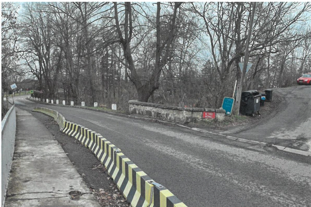
Pohled na mostovku a poprsní zídku na povodní straně od V.
