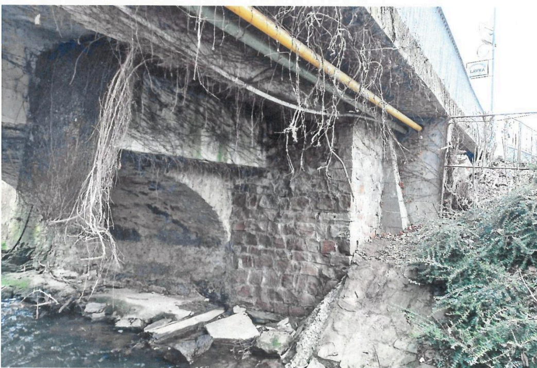
Západní mostní opěra s částí oblouku, vpravo dvě novodobá rozšíření mostku.
