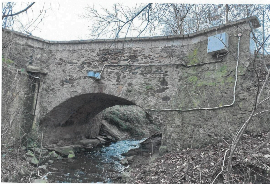
Pohled na povodní stranu mostku směrem od SZ.
