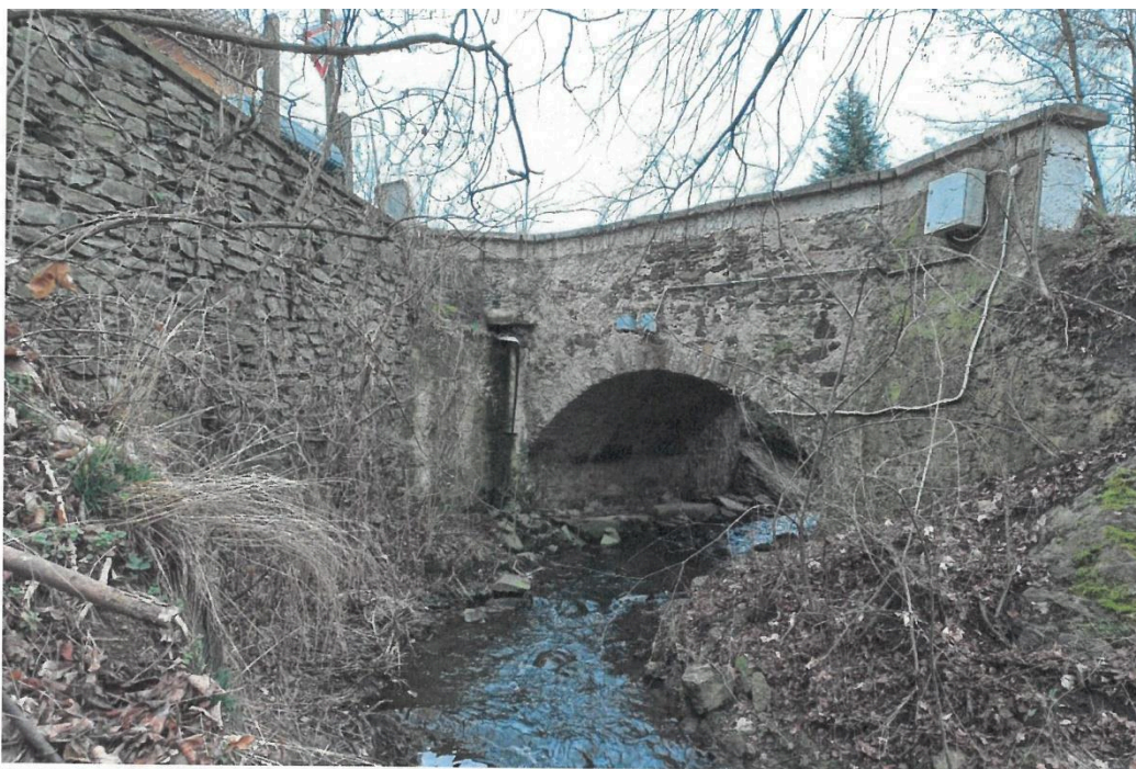
Pohled na povodní stranu mostku a tarasní zeď směrem od SZ.
