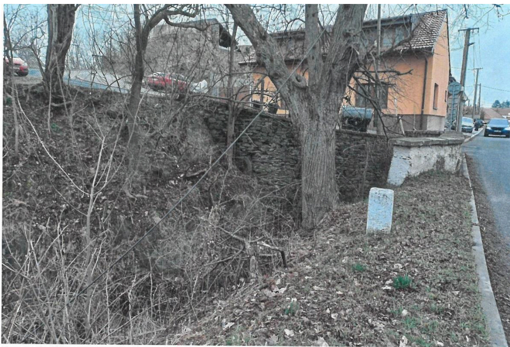
Poprsní zídka na povodní straně mostku, vlevo na ni navazující tarasní zeď a skála na JZ konci ostrohu.
