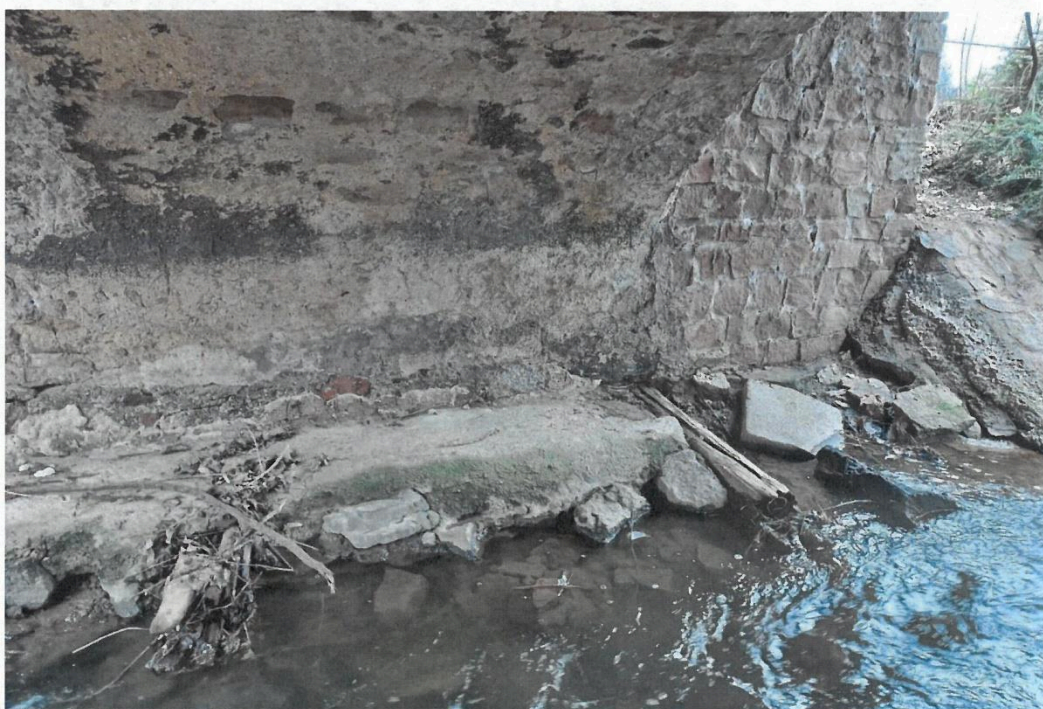
Východní mostní opěra, vpravo novodobě rozšířená; nad hladinou dva zbytky trámů zazděných do paty opěr při stavbě mostku.
