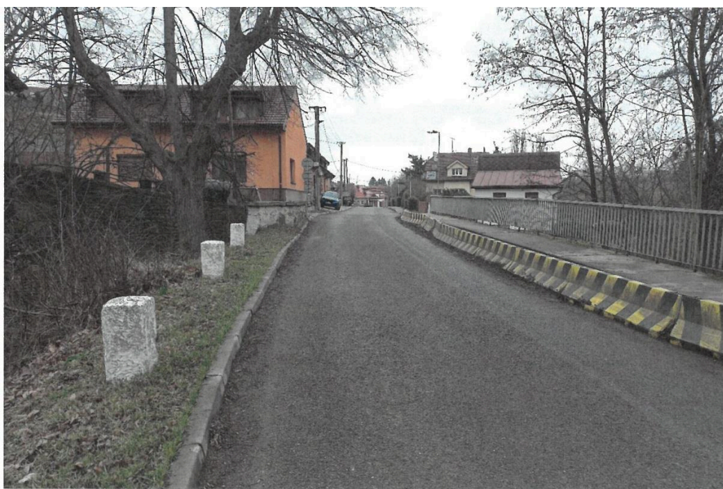
Pohled na mostovku od JV.
