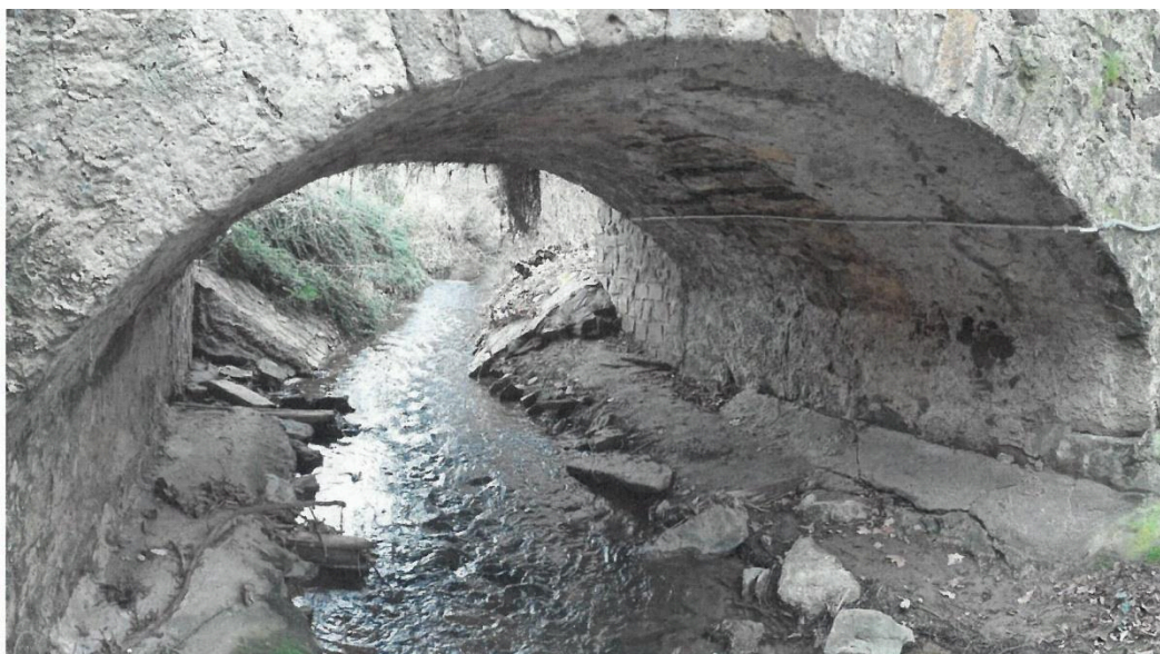
Klenuté pole mostku, pohled proti proudu potoka od S.
