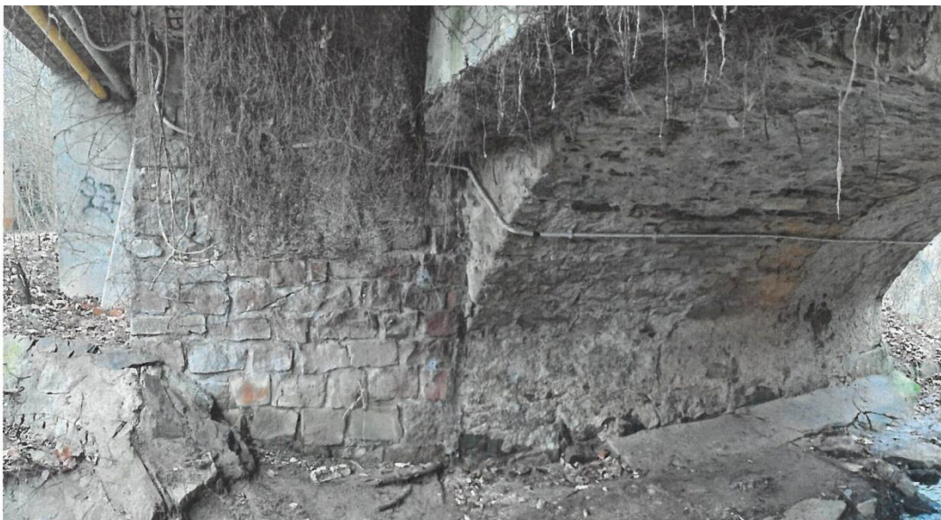
Západní mostní opěra s částí oblouku, vlevo dvě novodobá rozšíření opěry.
